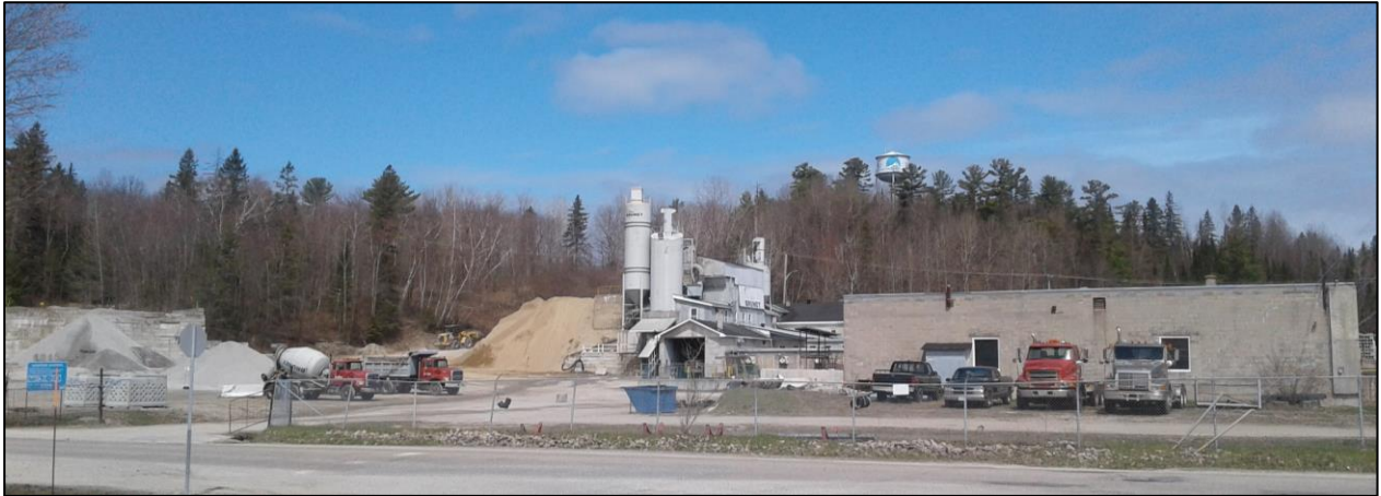
Figure 6.26 : Les équipements béton Brunet 2001 inc. rue Saint-Lionel à Maniwaki
