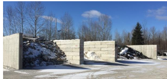
Section sud des nouveaux enclos
