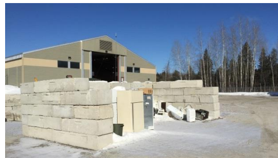
Enclos d'appareils froids - avant le retrait des halocarbures (Bâtiment de transfert en arrière-plan)
