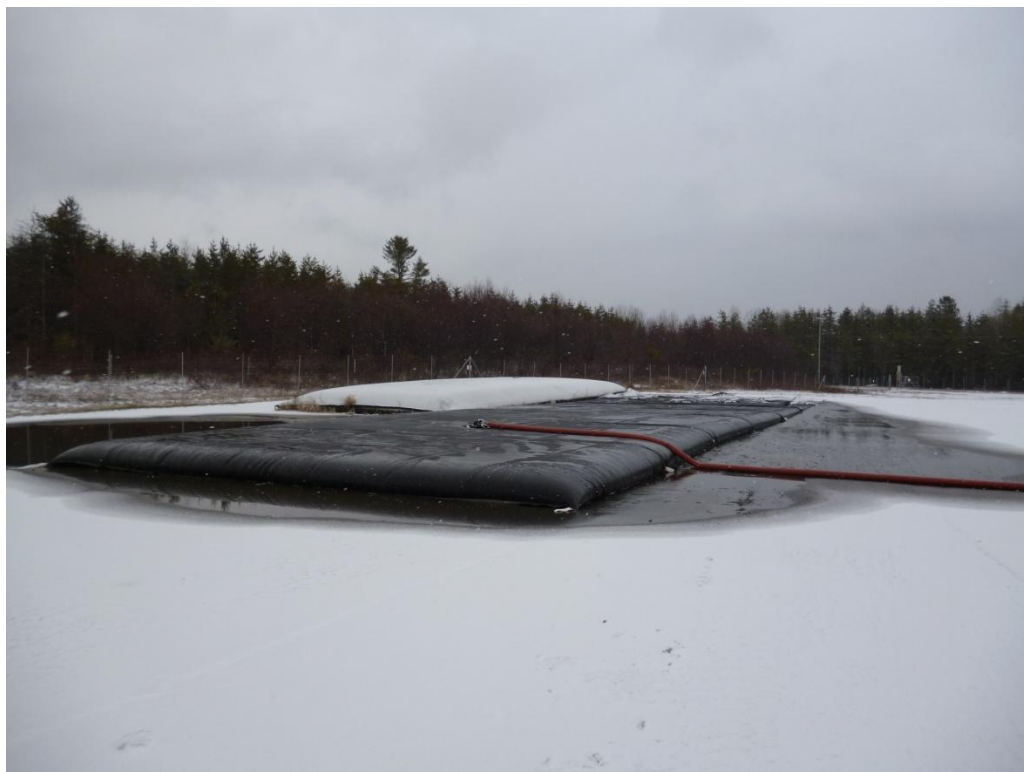
Déshydratation des sédiments soutirés du bassin 4 - Terratube
