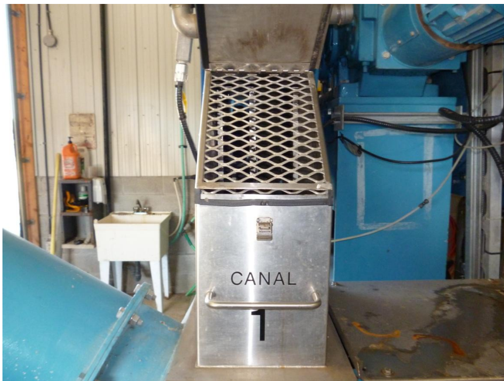
Grillage sur la trappe 1 de vérification des roues du presseur
