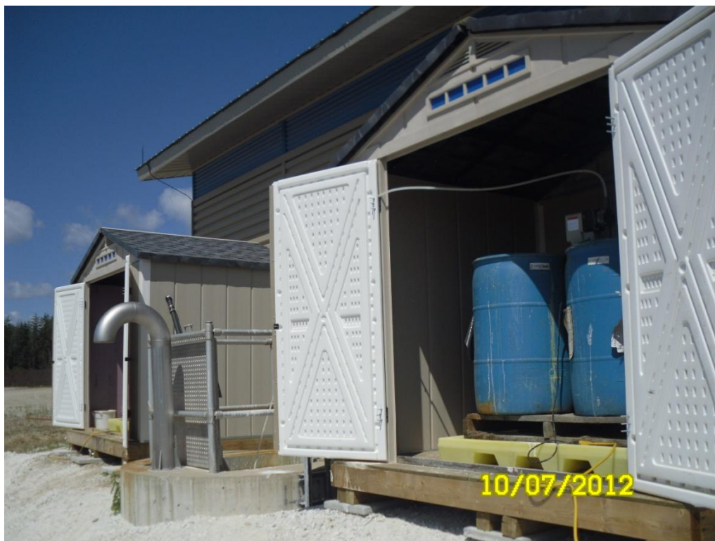
Remise d'entreposage de produits chimiques
