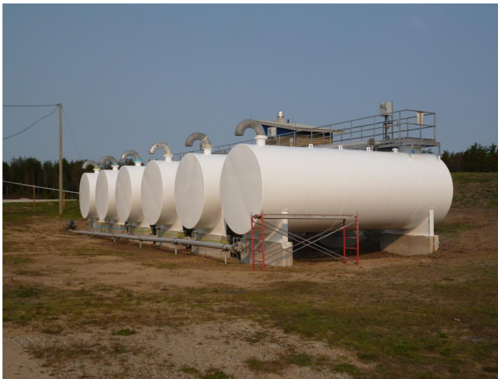
Réservoirs après la peinture
