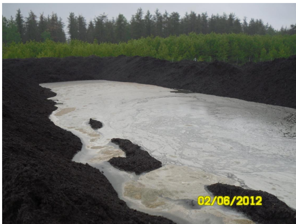
Digue rempli par le bassin 4
