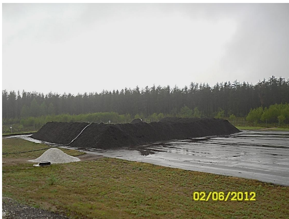
Digue construit avec les lots de compost de 2009-2010-2011
