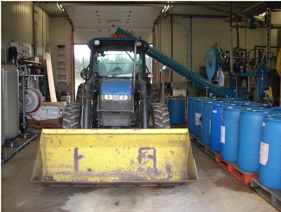
Vue de l'intérieur de l'usine de traitement des boues.
