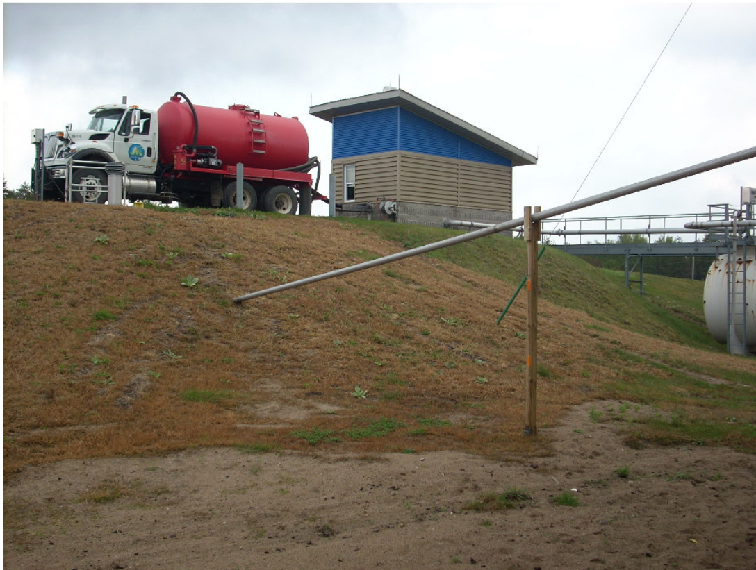
Tuyau de raccordement de la station de pompage des boues vers l'usine de traitement.
