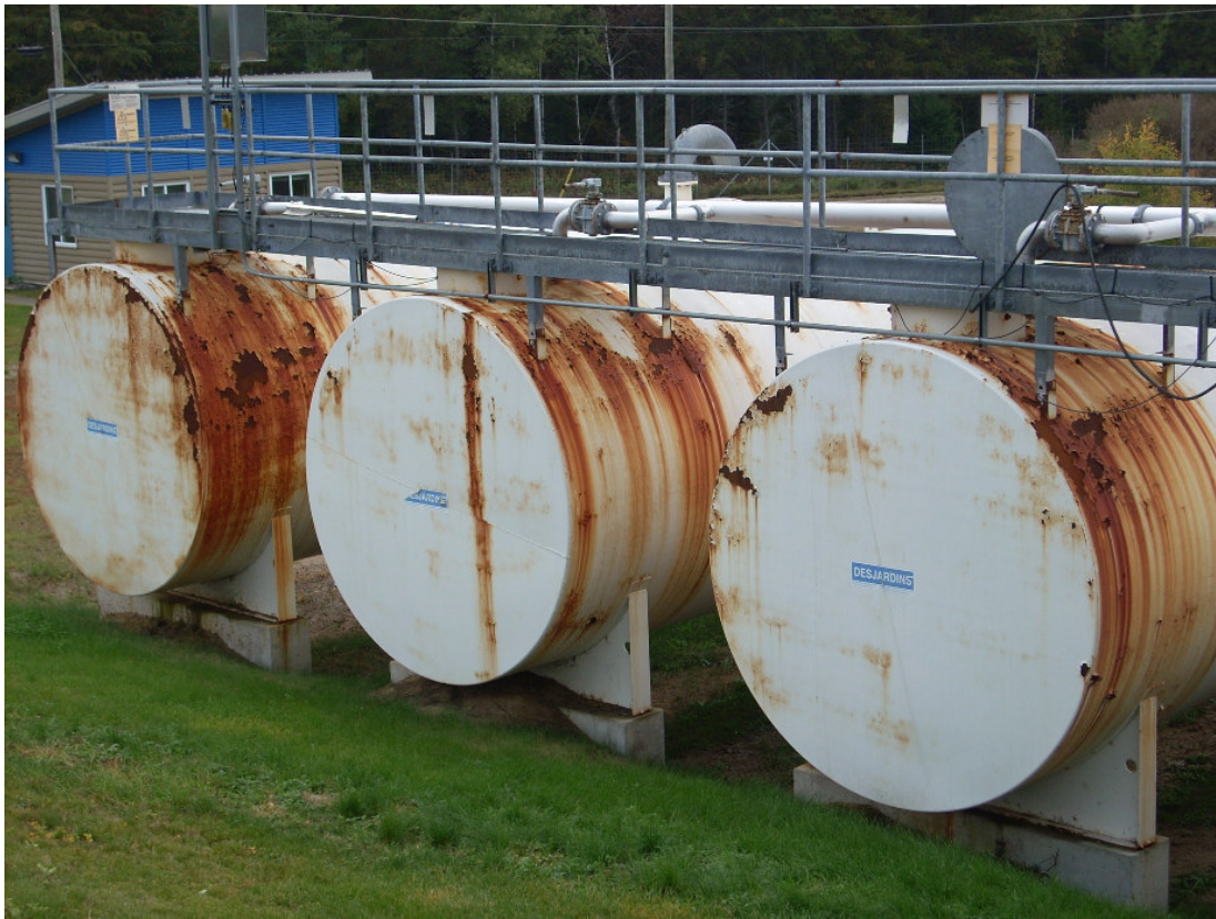
Réservoirs de réception des boues à peindre pour l'année prochaine.
