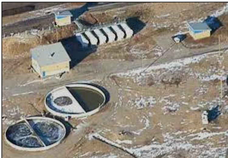
Figure 1 - Vue aérienne du centre de traitement
